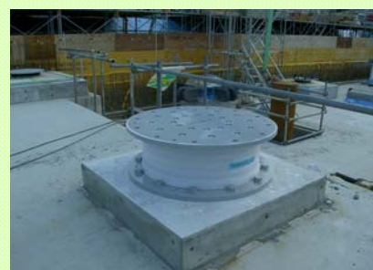
写真免震装置(積層ゴム)設置状況
