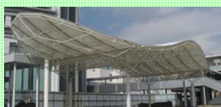
屋根の下はゴムチップ 舗装の広場
