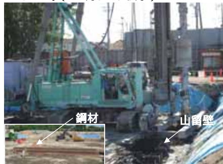
写真左 山留壁打ち込み中
