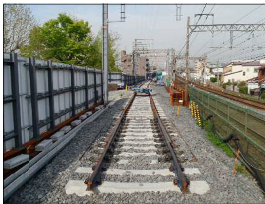
仮線路（名古屋方面）工事中
