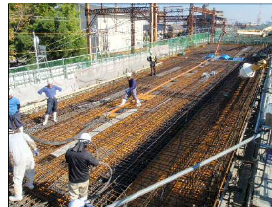
高架橋本体工事中
