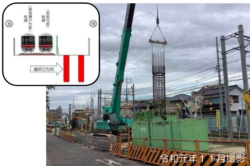
基礎杭施工状況
