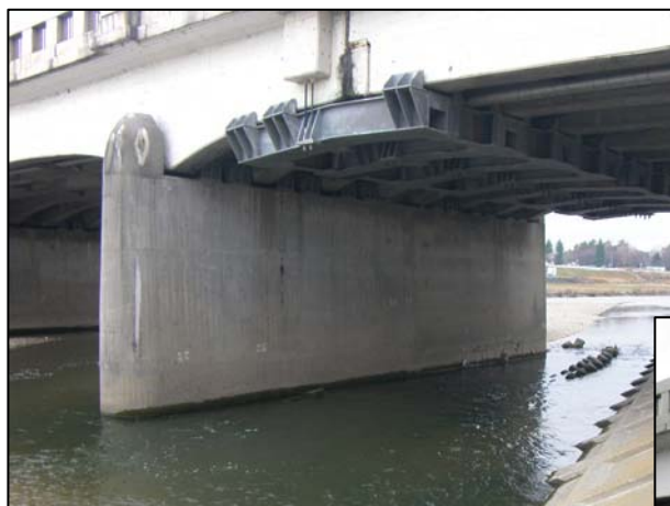
矢田川橋：設置前
