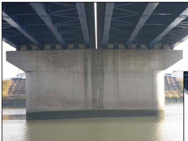
新前田橋：設置前
