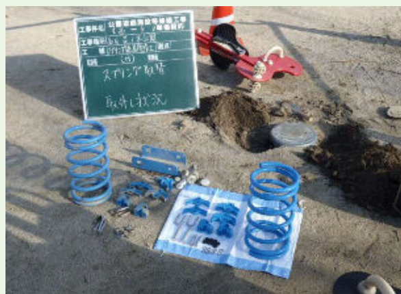
スプリング遊具のばね取替 (7年毎)
