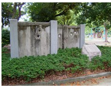
空襲で被弾したコンクリート塀
