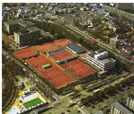
名城水処理センター
