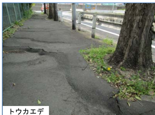
根上がりによる歩道の段差や亀裂
