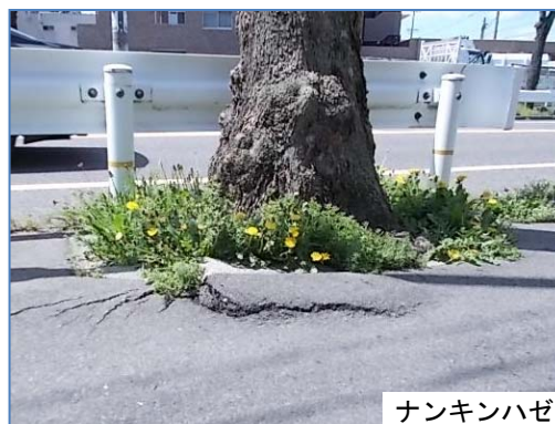
根上がりによる歩道の段差や亀裂
