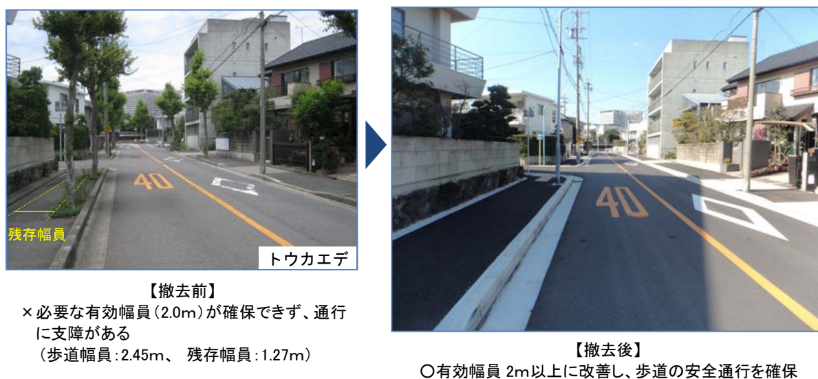
図－13 街路樹撤去の例
