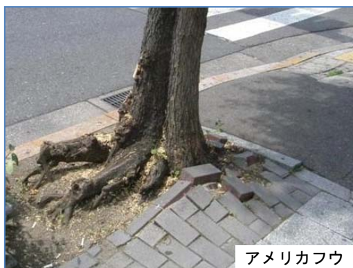
根上がりによる舗装ブロックの浮き上がり
