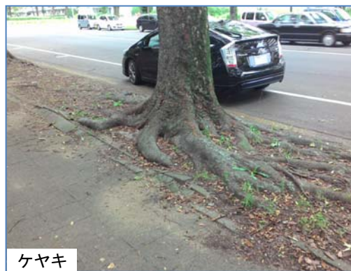
根上がりによる舗装ブロックの浮き上がり
