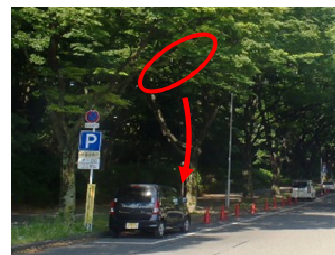
枯れ枝の落下
