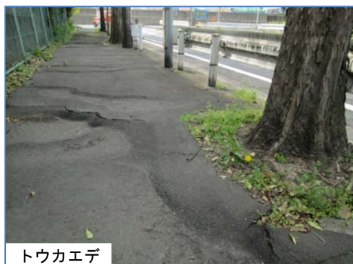
根上がりによる歩道の段差や亀裂
