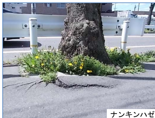
根上がりによる歩道の段差や亀裂
