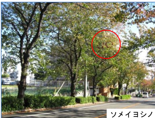
道路標識を隠している街路樹
