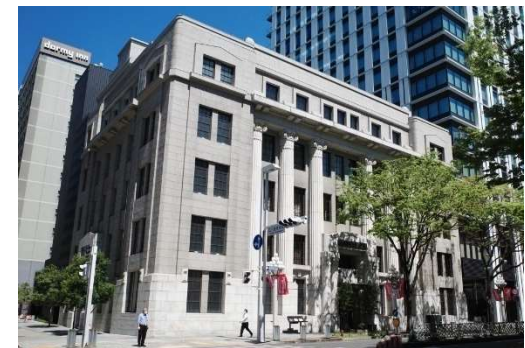
旧名古屋銀行本店ビル (都市景観重要建築物)
