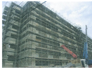
市営住宅の外壁改装
