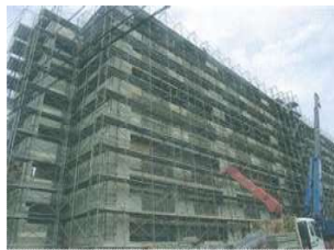
市営住宅の外壁改装
