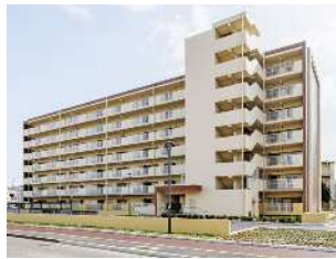
市営住宅の建替えによる耐震化
