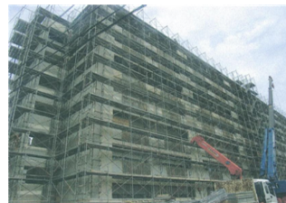
市営住宅の外壁改装
