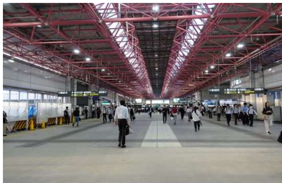
連絡通路(床、壁面、天井トラス
