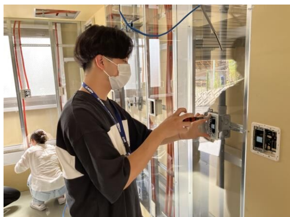
研修ラボでは電気工事が誰でも体験できます
