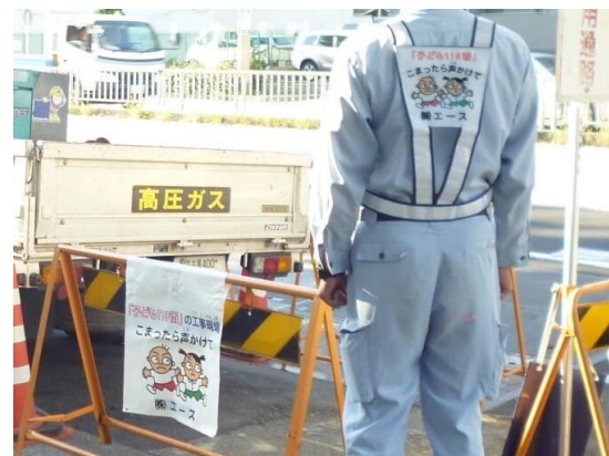
子どもに優しい工事現場
