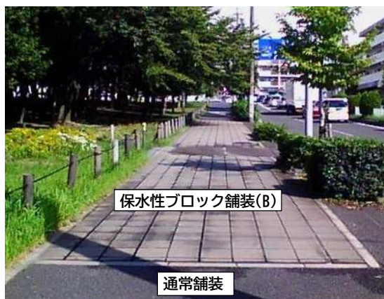
保水性ブロック舗装（B）の写真（左）とサーモカメラ画像（右）
