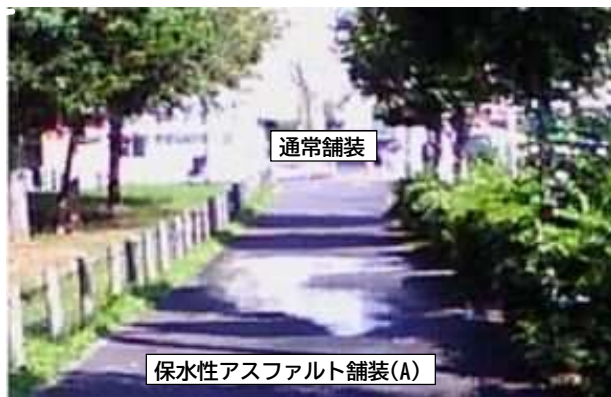
保水性アスファルト舗装（A）の写真（左）とサーモカメラ画像（右） 撮影日：9月18日（送水時間：54min/h）
