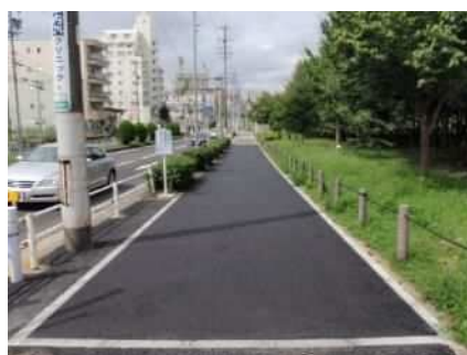
A 保水性アスファルト舗装
