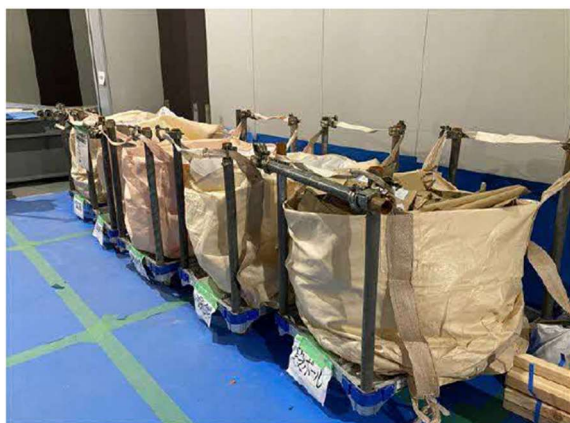
写真 7-1-2-6 副産物の分別、再資源化
