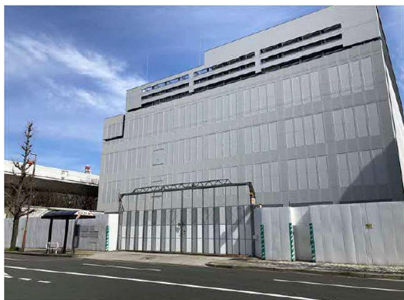
写真 7-1-2-1 仮囲い等の設置状況
