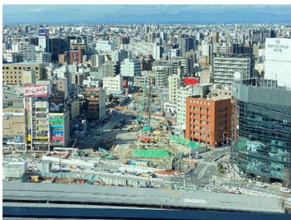
写真 3-2-3-1(11) 名古屋駅（西工区）
