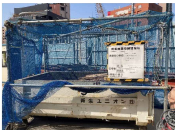
写真 7-1-3-17 副産物の分別、再資源化
