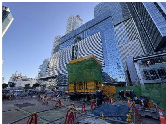
写真 3-2-3-1 (6) 名古屋駅（東山線工区）
