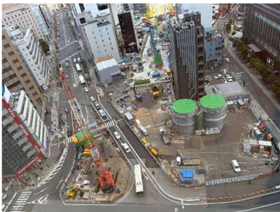
写真 3-2-3-1 (5) 名古屋駅（東山線工区）
