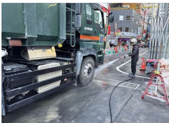
写真 7-1-3-9 資材及び機械の運搬に用いる 車両の出入口、周辺道路の清掃及び散水、 タイヤの洗浄
