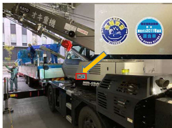
写真 7-1-2-2 排出ガス対策型建設機械の採用 低騒音型建設機械の採用
