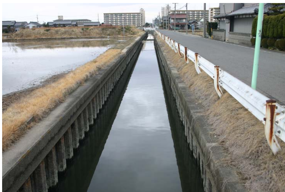
図9.1.11- 1 事業実施区域内にある水路の状況
