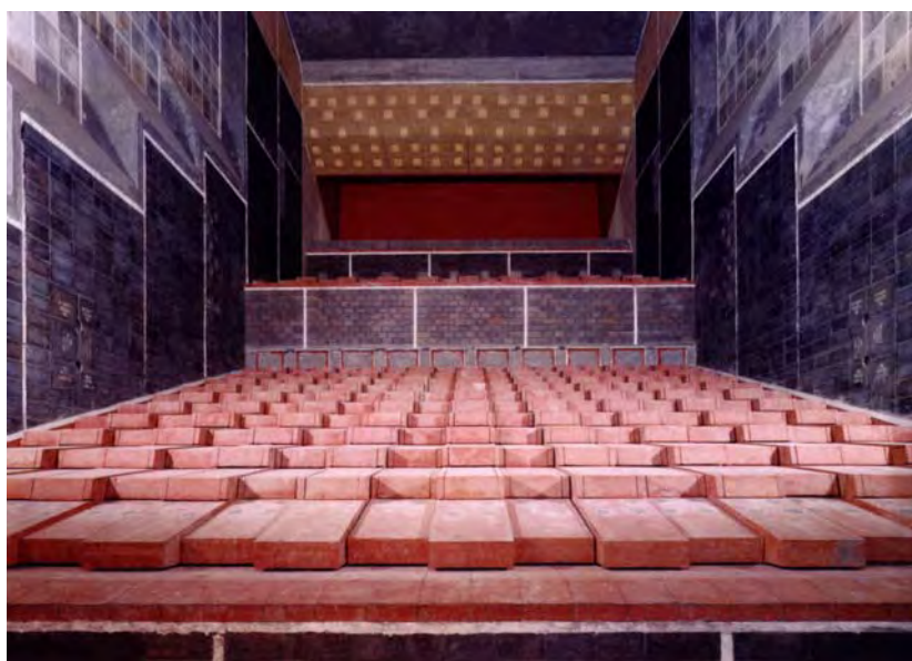
写真 2-3-2 ストーカ炉内部（図 2-3-6 の □ から見たところ）
