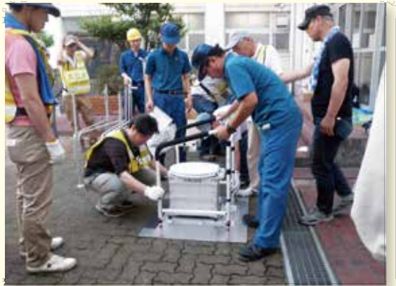
仮設トイレの組み立て
