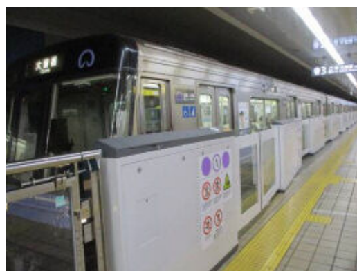
可動式ホーム柵の整備
