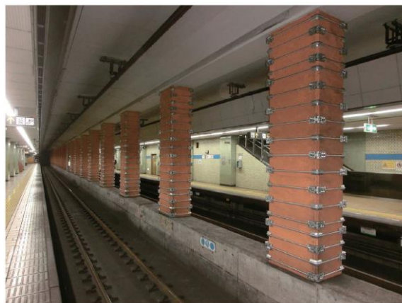
※耐震補強を施した中柱（イメージ）
