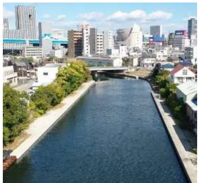
護岸整備状況
