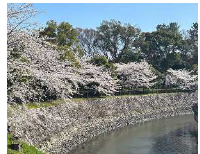
河川改修 (景観に配慮した護岸整備)
