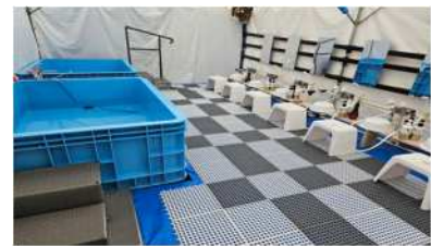
仮設入浴設備
