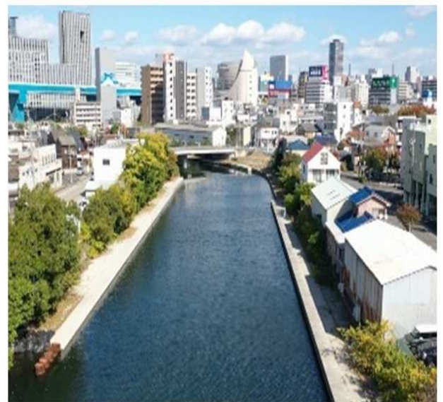
護岸整備状況
