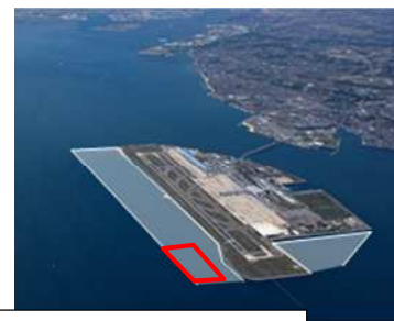
浚渫土砂処分場 埋立土量 約3,800万 m^3
