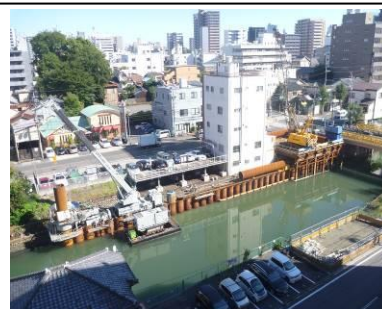
護岸改修と河道掘削
