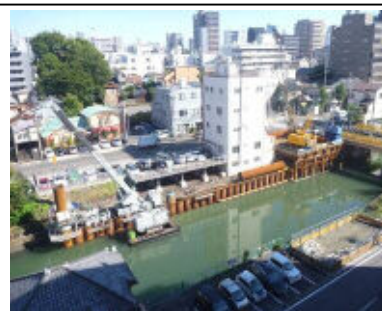
護岸改修と河道掘削
