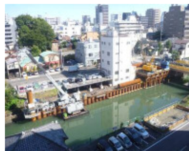
護岸改修と河道掘削
