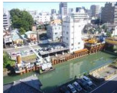
護岸改修と河道掘削
