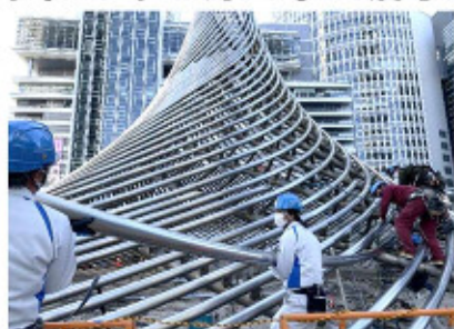
写真：「飛翔」の一部部材解体の様子
