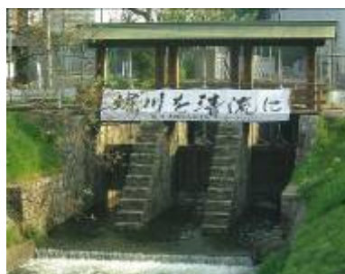
維持用水の確保 (庄内川からの導水)
