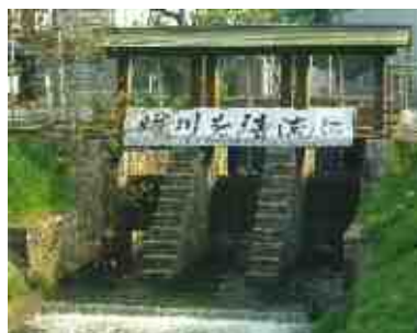
維持用水の確保 (庄内川からの導水)
