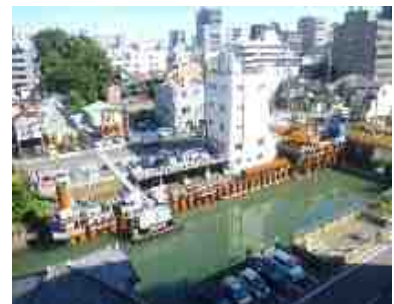
護岸改修と河道掘削
