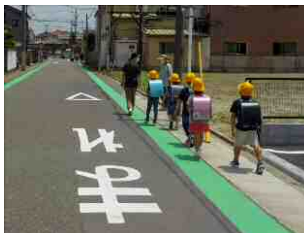
路肩カラー舗装の対策事例
