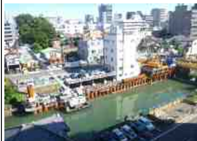
護岸改修と河道掘削
