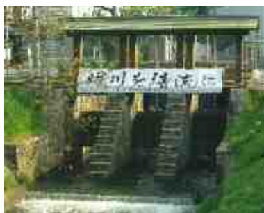
維持用水の確保 (庄内川からの導水)
