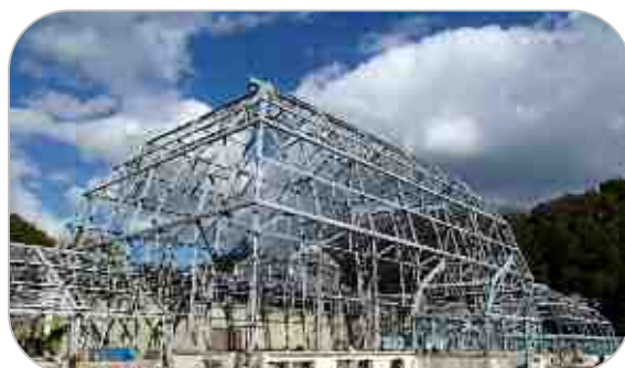
歴史文化的施設の保全・活用 重要文化財温室前館の保存修理（植物園）
