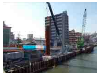
護岸改修と河道掘削
