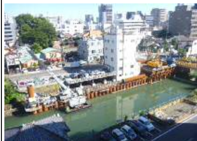
護岸改修と河道掘削
