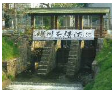
維持用水の確保 (庄内川からの導水)
