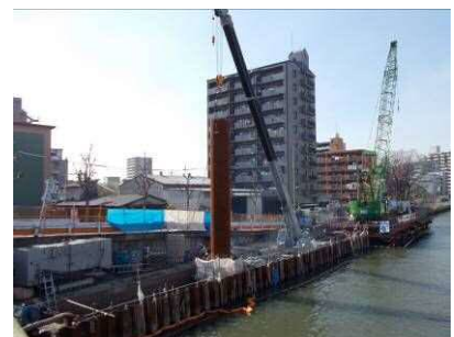
護岸改修と河道掘削
