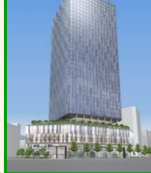
大名古屋ビルディング ＜平成27年竣工予定＞
