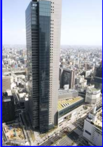
ミッドランドスクエア ＜平成18年9月竣工＞
