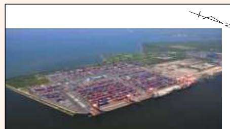
鍋田ふ頭コンテナターミナル
