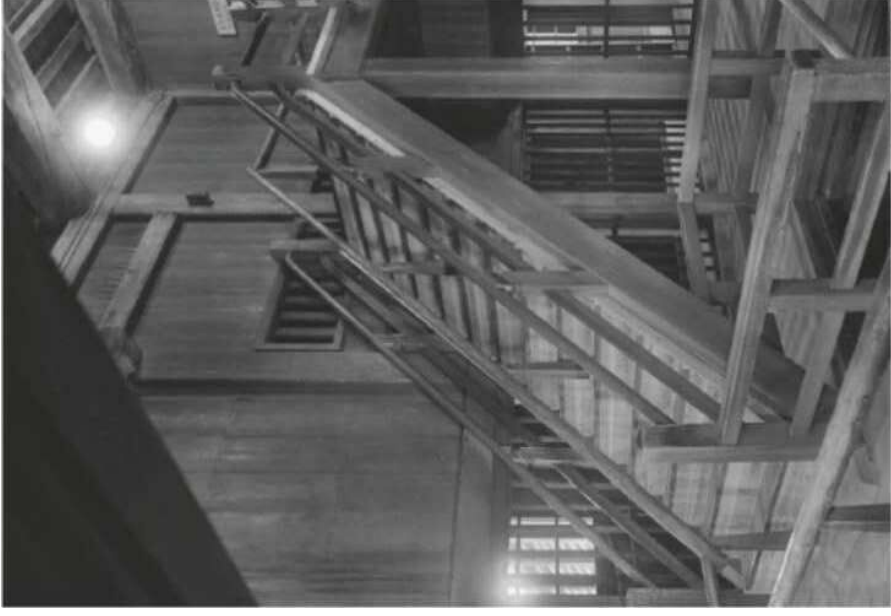
焼失した大天守の最上階の階段 （ガラス乾板写真）
