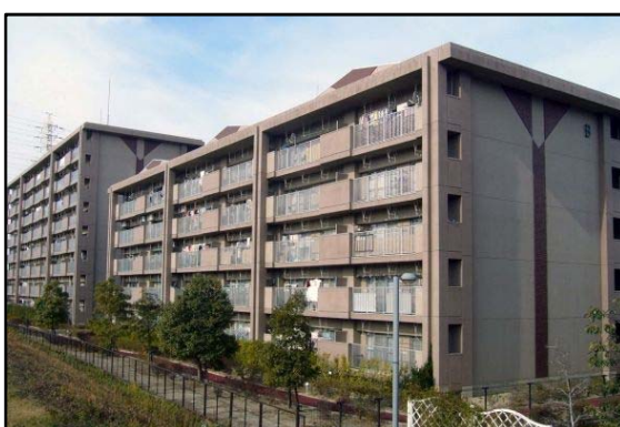
シティファミリー小幡宮ノ腰 （平成 11 年度建設）
