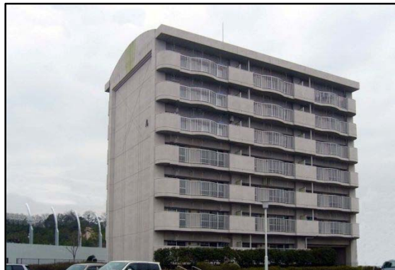
シティファミリー小坂（平成 6 年度建設）
