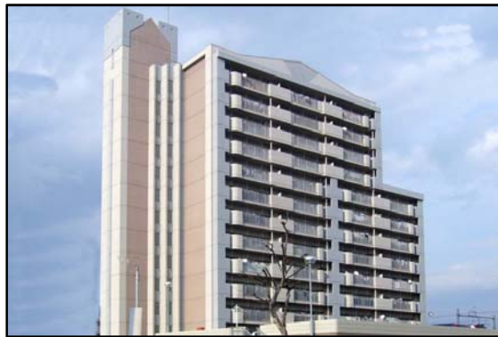
シティファミリー吉良（平成 8 年度建設）
