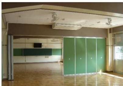
可動間仕切り付教室
