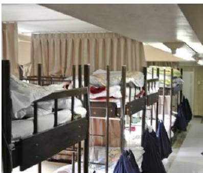
仮眠室（改修前）
