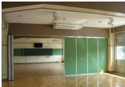
可動間仕切り付教室
