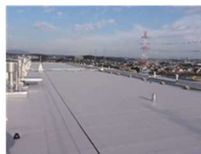
屋根防水の改修
