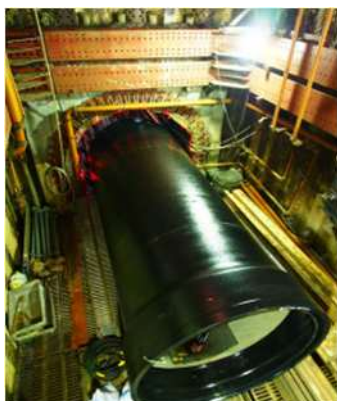
犬山系導水路A管の更新工事
