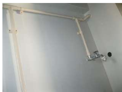
屋内給水管の改修
