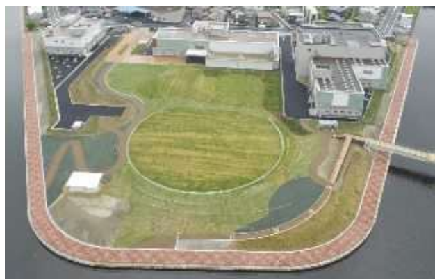
改築後の露橋水処理センター
