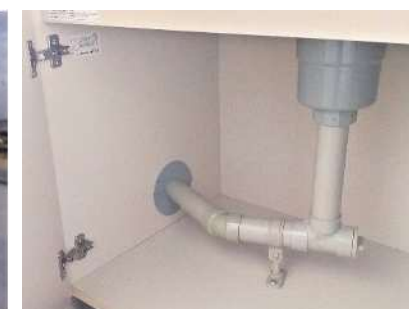
屋内排水管の改修
