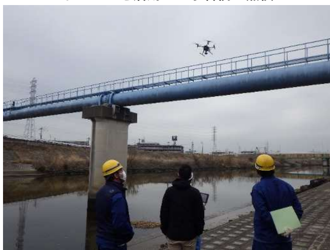
ドローンを活用した水管橋の点検
