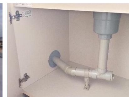
屋内排水管の改修
