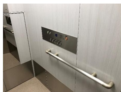
エレベーター更新
