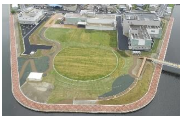
改築後の露橋水处理センター
