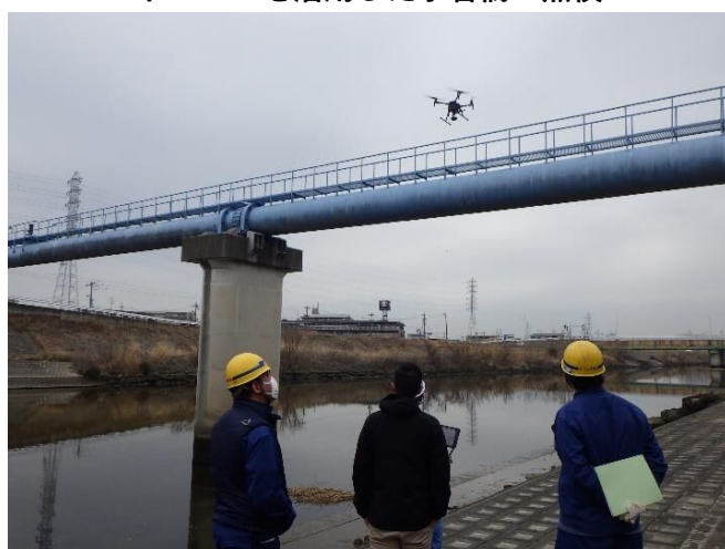
ドローンを活用した水管橋の点検
