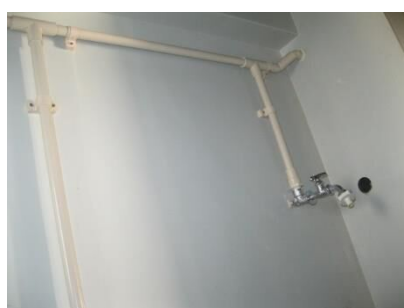
屋内給水管の改修
