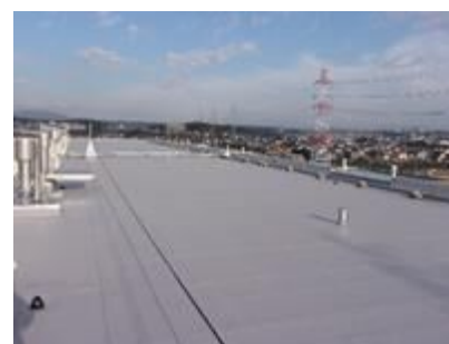
屋根防水の改修
