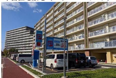
市営住宅敷地（コインパーキング）
