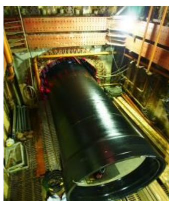
犬山系導水路A管の更新工事
