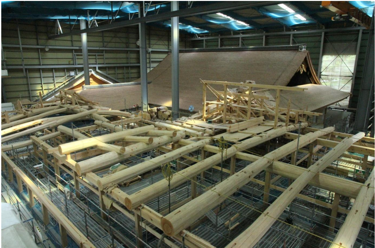
※手前の建物が復元工事中の対面所。奥の建物は完成・公開済の表書院。
