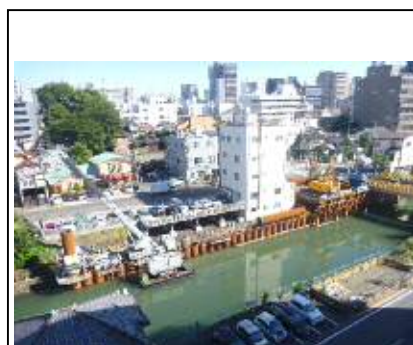
護岸改修と河道掘削
