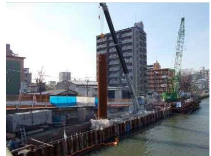
護岸改修と河道掘削
