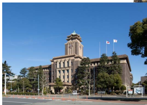
国指定重要文化財 名古屋市役所本庁舎
