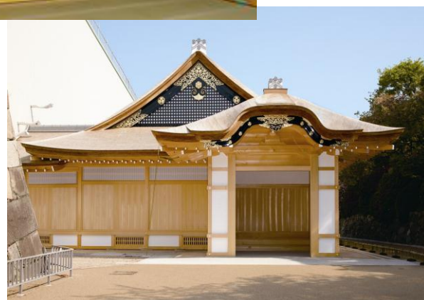
玄関・車寄外観
