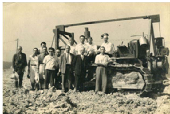
53 平針小学校造成工事開始 (昭和29年)
